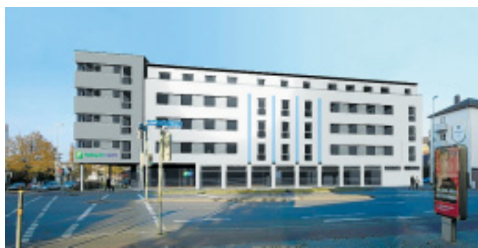
Genehmigt: Der elf Millionen Euro teure Neubau, hier von der Friedrich-Ebert-Straße aus gesehen, umfasst vier Geschosse plus Staffelgeschoss. Links die obere Berliner Straße.
