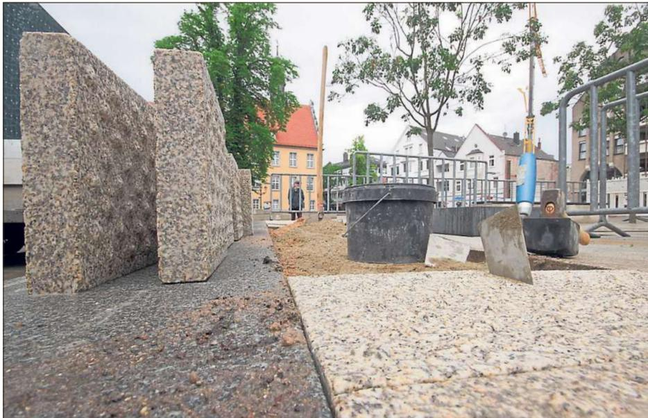
Deutlich zu erkennen sind die Noppen auf den hochkant stehenden Platten, die oben vor der obersten Stufe am Wasserband auf dem Berliner Platz verlegt werden. Außerdem sollen an den drei Seiten mit Stufen Handläufe installiert werden.
